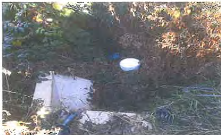
Foto 2 Probeentnahmestelle MP 1 Einleitstelle/ Entwässerungsgraben
