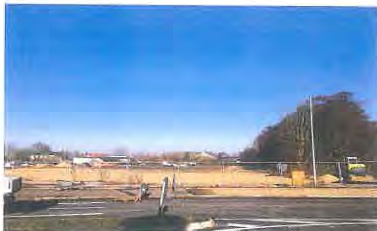
Foto 1 Blick nach Norden auf eine Teilfläche des Grundstücks Heider Straße 32 in 25704 Meldorf
