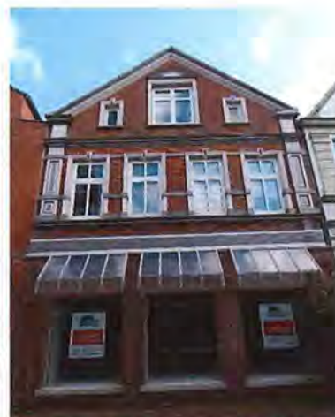
Abbildung 25: Auf Vordächer ist zukünftig zu verzichten
