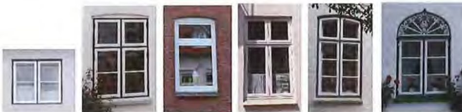
Abbildung 15: Typische Fensterformate in Meldorf
