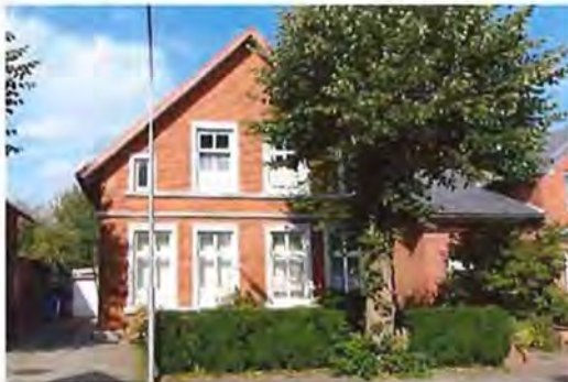
Abbildung 20 : Ziegelmauerwerk in rot mit plastisch hervortretende Gliederungselemente in hellerer Tönung
