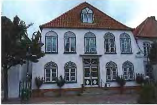
Abbildung 18: unverputztes geschlämmtes Backsteinmauerwerk, im Sockelwerk ist das Ziegelmauerwerk sichtbar
