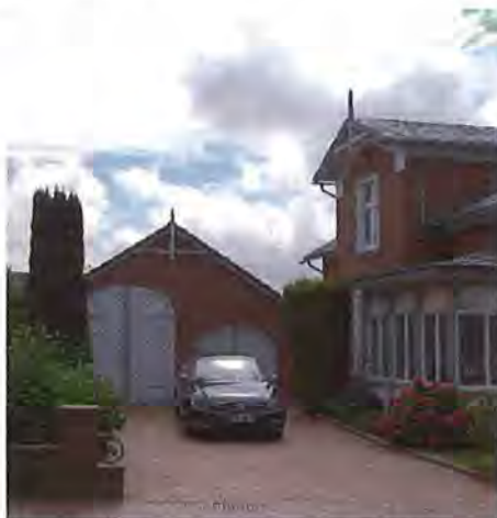
Abbildung 23: Nebengebäude passt gestalterisch zu Hauptgebäude
