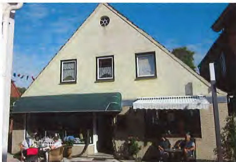
Abbildung 26: Feststehende Markise und bewegliche Markise ohne Bezug zueinander oder zur Fassade sind unzulässig
