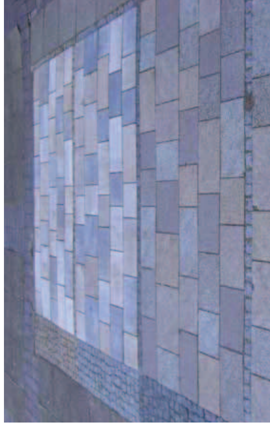
Musterpflasterfläche neuer Belag Fußgängerbereiche
